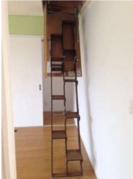
折り畳み互い違い階段施工例茨城県 W 様出したところ
