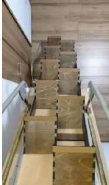
折り畳み互い違い階段施工例千葉県ちばっしー様 上からの写真
