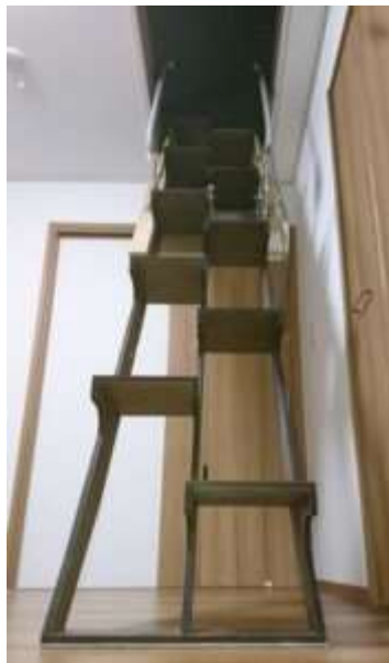
折り畳み互い違い階段施工例千葉県ちばっしー様 下から見上げたところ
