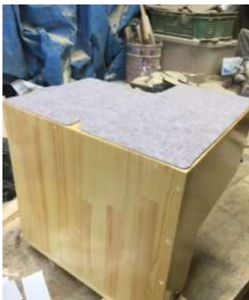
折り畳み互い違い階段の段がすべて天井内で仕舞えないときの台
