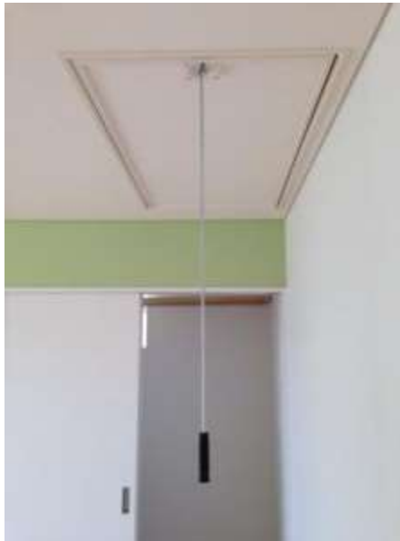
折り畳み互い違い階段施工例茨城県 W 様 締めたところ
