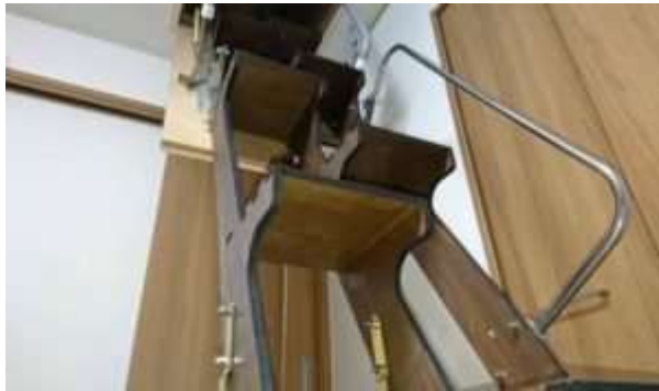
折り畳み互い違い階段施工例千葉県ちばっしー様 下から拡大
