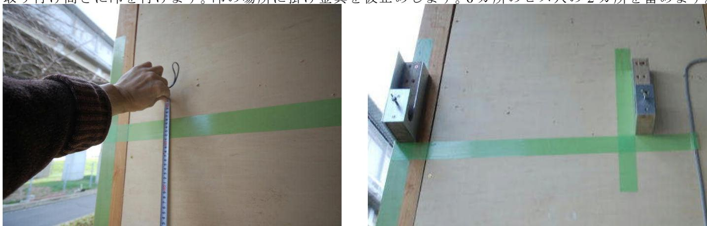
掛け金具の取り付け面は同一面であればなりません。下の写真では左側の取り付け面が斜めになっています。同一面にするため写真では紙を挟んでいます。適宜同一面になるよう調整下さい。
