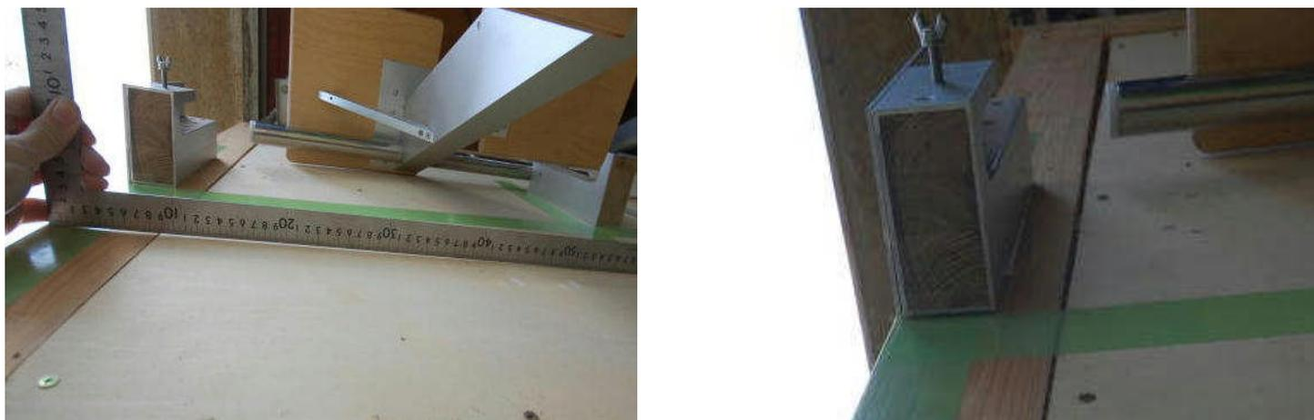
掛け金具にロフトくんを掛けます。壁からの距離が同じになるように調整します。
