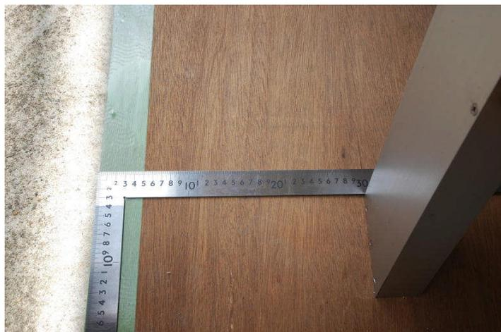
同じになるように掛け金具の取り付け位置を調整します。写真の場合はロフトくんの下部を左側に移動させるため右側の掛け金具を下げます。通常のロフトくんの大きさでは調整すべき長さの 4 分の 1 を移動させます。
